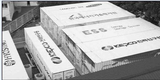
ESS(에너지 저장 장치)의 실물 모습. 컨테이너 하나 크기에 약 1MW의 전력을 저장할 수 있다.
